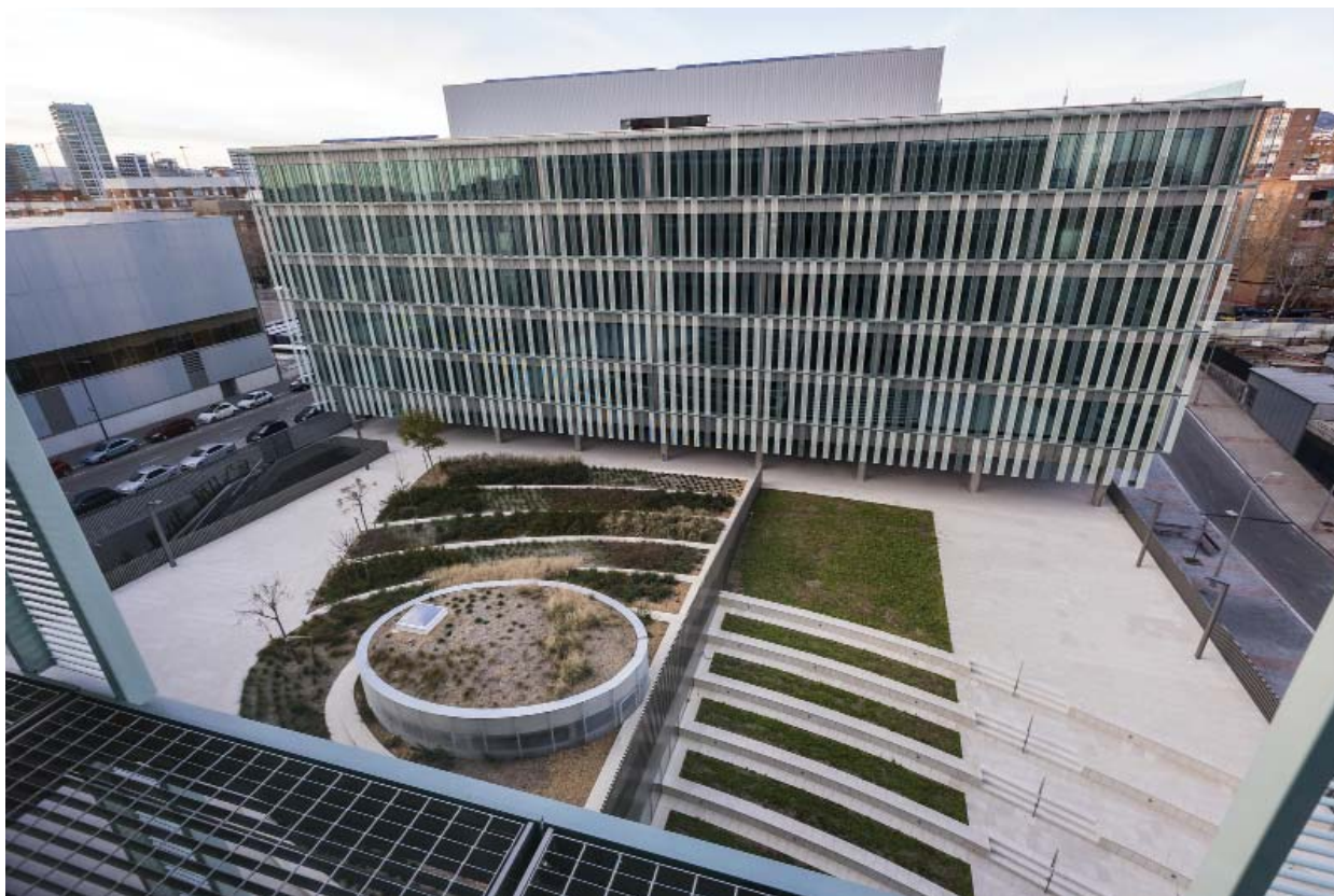
Vista general del nou complex d'oficines
