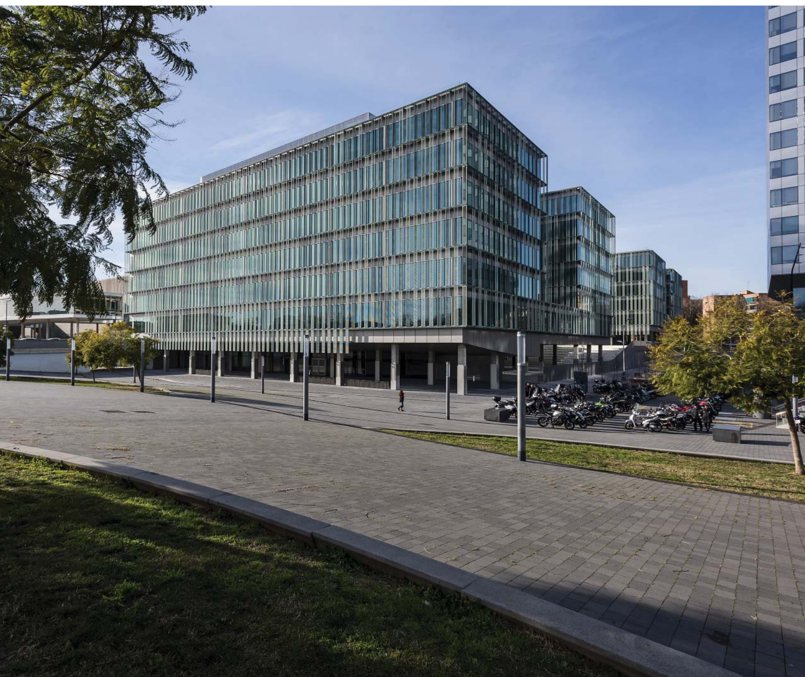
Vista general del conjunt d'oficines des de la plaça d'accés principal
