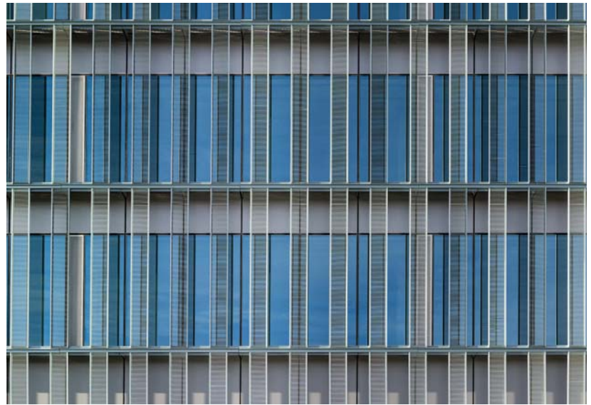
Detall de la doble façana del conjunt amb els mòduls verticals de xapa
