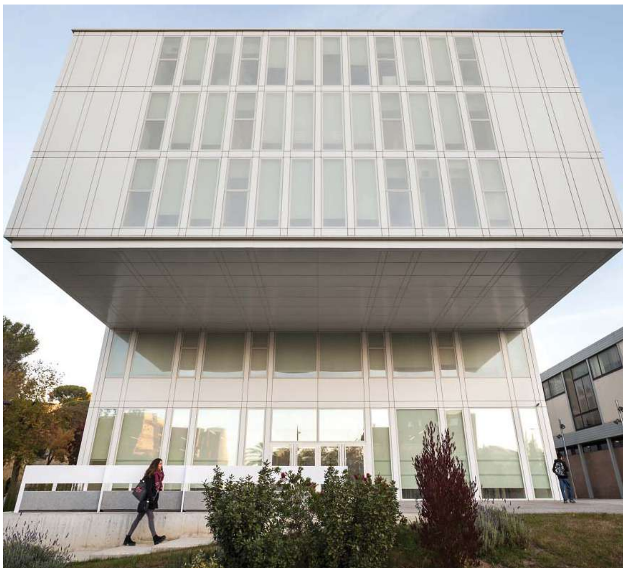
El voladís està revestit amb fals sostre de panell composite
